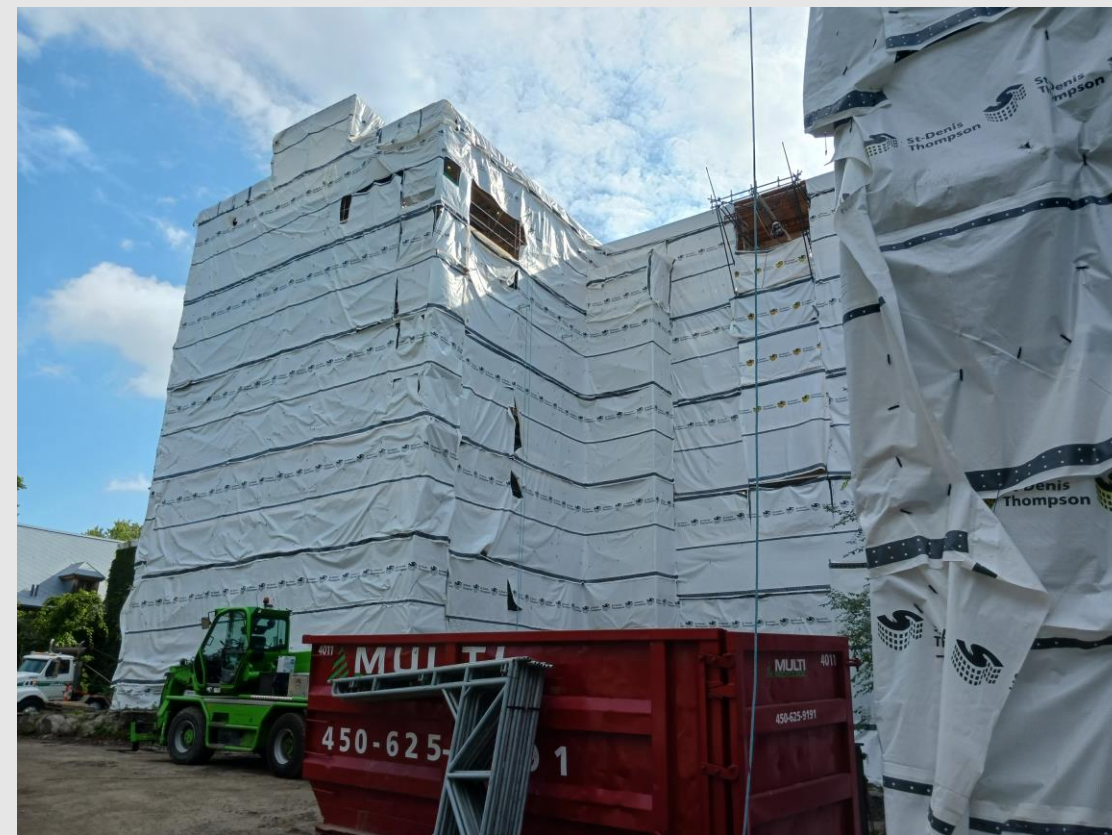
Bâtiment toilé pour empêcher la propagation des poussières
